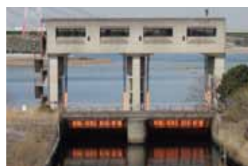
●河川などの水位監視
