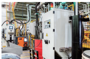
●設備の稼働状況
