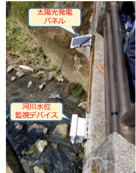
現場設置事例
