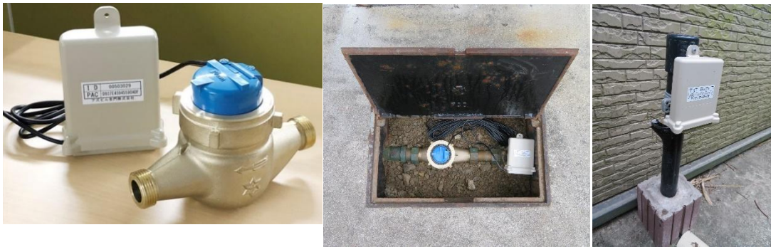
水道メーターの設置施工例
