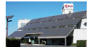
佐倉ソーラーエネルギーセンター (監視センター)
