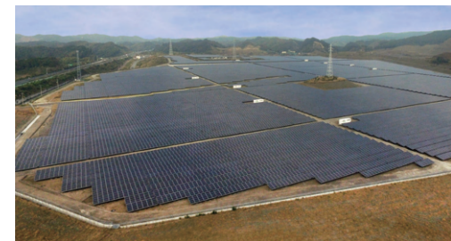
千葉県富津市 出力:約42MW
