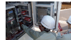
定期点検 (性能診断)
